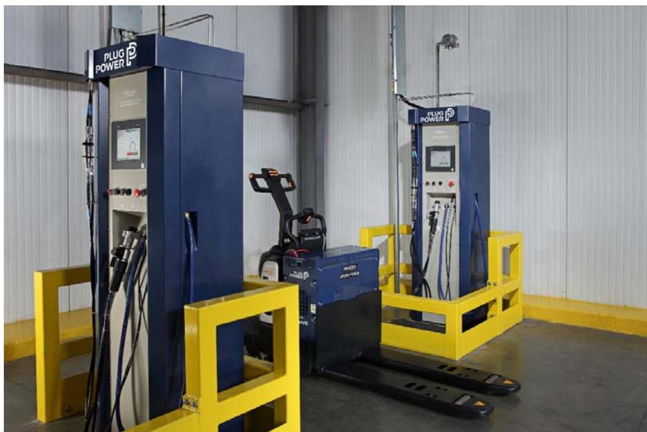
図. Plug Power社の屋内水素充填設備
